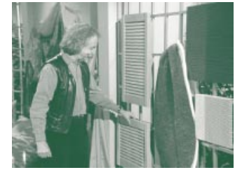
Das Schafwollvliese verschwindet hinter den seitlich angebrachten Holzleisten
